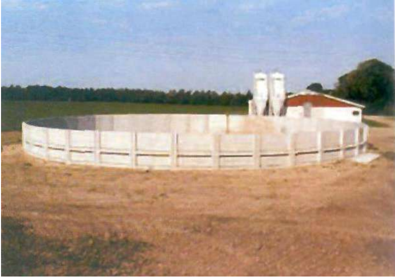
Шламний резервуар для зберігання гною
