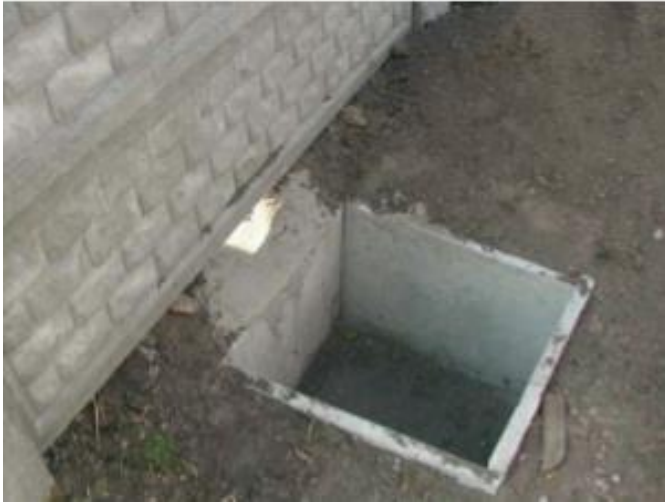
Приклад будівництва резервуара зі шматків бетонних плит.
