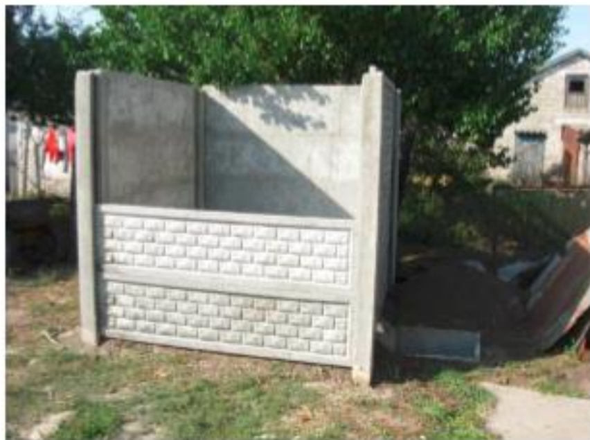
Готове гноєсховище розміром на 2 м x 2 м
