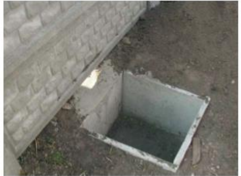
Приклад будівництва резервуара для стоку вод (із шматків парканових плит)
