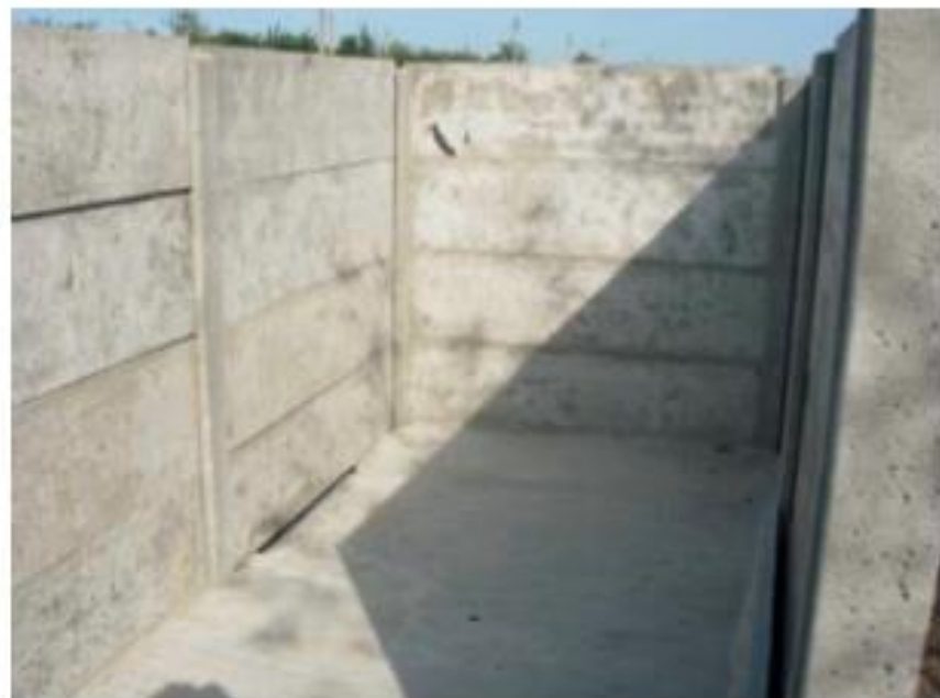
Внутрішній вигляд готового гноєсховища (із парканових плит)
