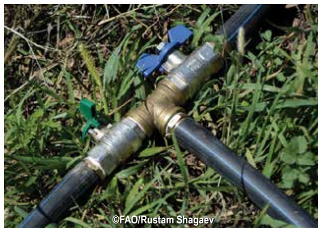
Вид раздаточных линий капельного орошения в подробностях (Таиланд)
