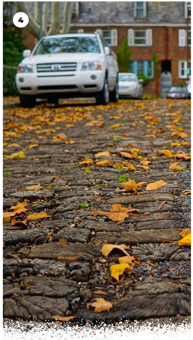
Зображення: 1 - проникна поверхня в лісопарку «Білогорща» у місті Львів (Україна); 2 - облаштування проникної дороги у місті Портленд (США); 3 - водопроникна доріжка у парку в місті Краків (Польща); 4 - дорога із дерев'яної бруківки у місті Піттсбург (США); 5 - інклюзивна проникна доріжка в Богуцькому парку у місті Катовіце (Польща)
